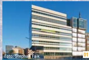
Bürogebäude WB57 Willy-Brandt-Straße 57 Gnosa Architekten, Hamburg
