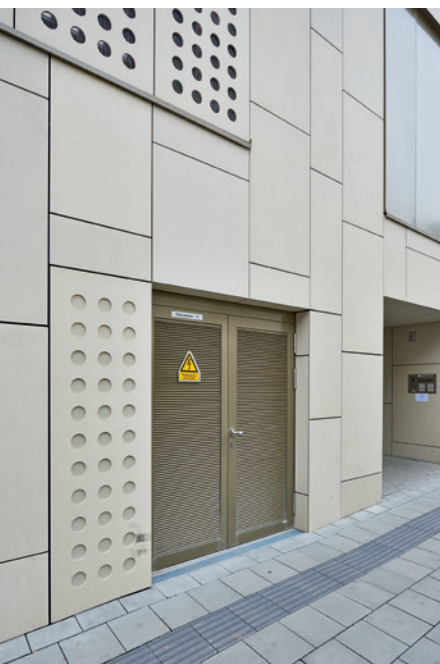
Außentür mit Lüftungslamellen.
