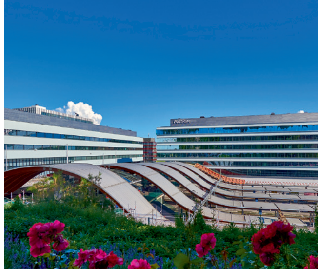
An den geschwungenen Dächern der Bahnsteige wird noch gearbeitet.
