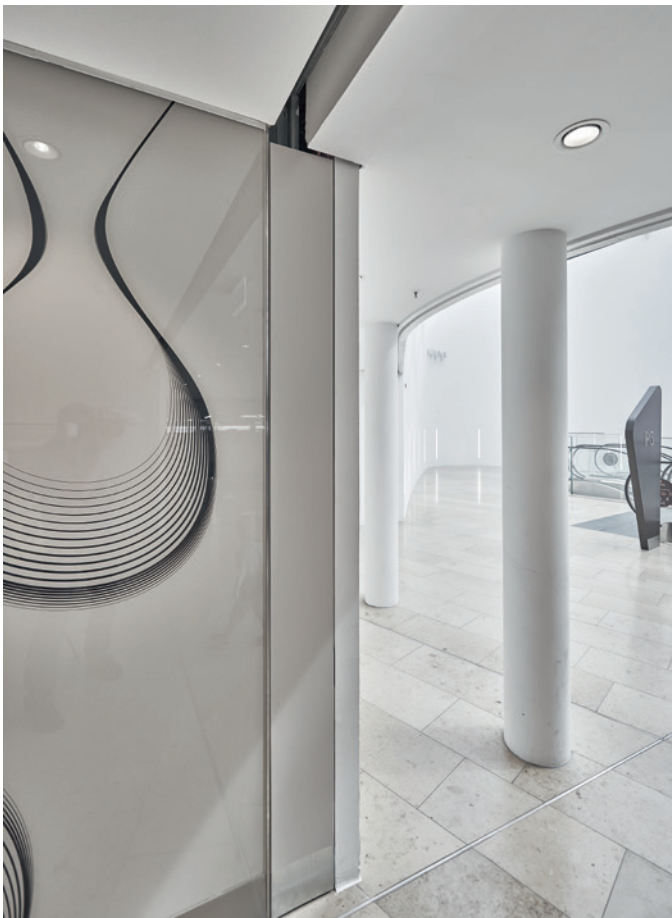
Das Feuerschutz-Schiebetor verbirgt sich hinter einer Nischenklappe.
