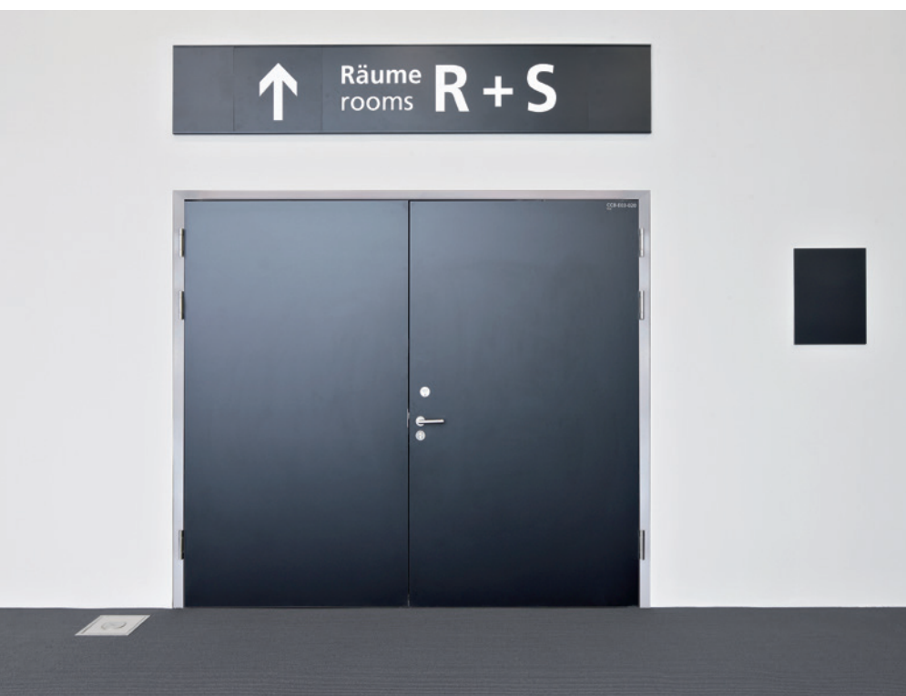
Die Holzwerkstoffzargen mit Aluminiumdecklage unterscheiden sich optisch nicht von Aluminiumzargen.
