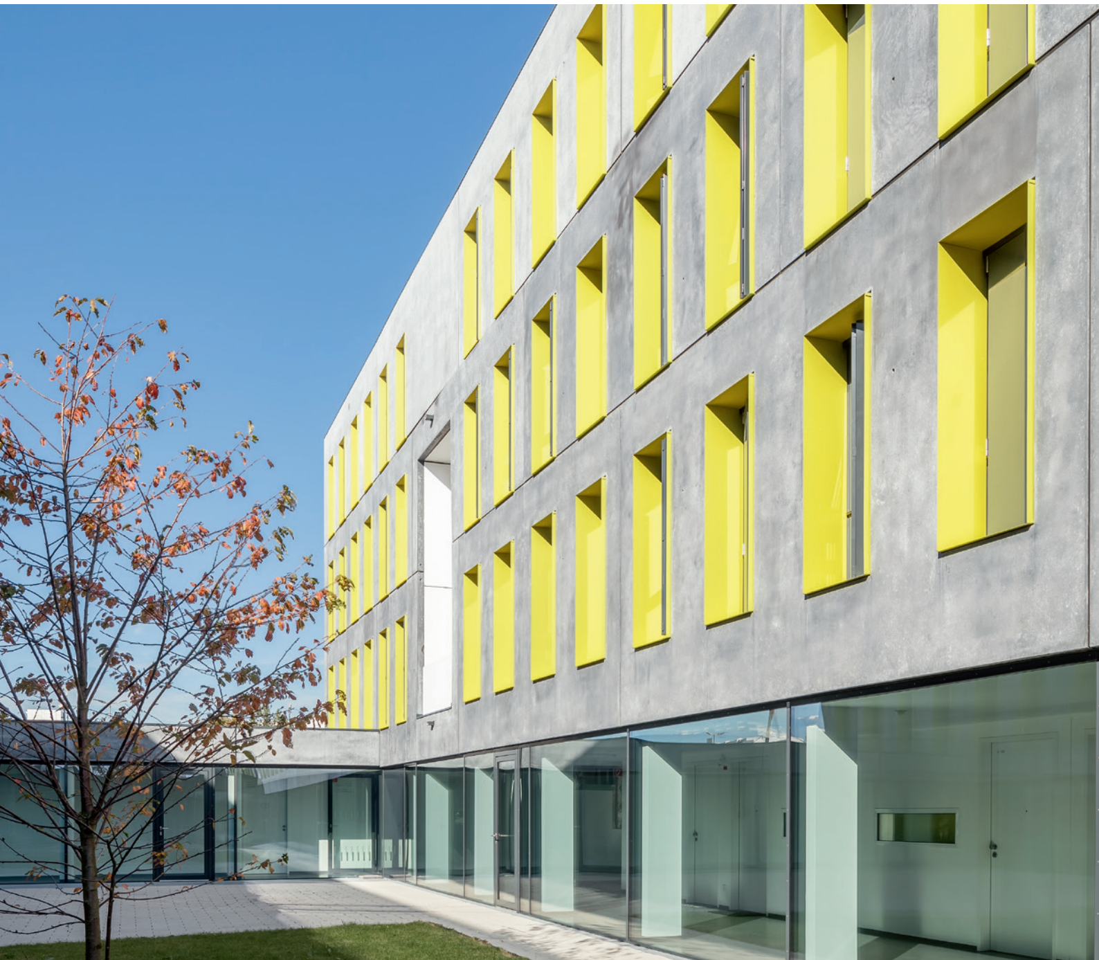
Die Fassade besteht aus Sandwich-Elementen. Durch das einfache Raster konnte größtenteils mit Fertigteilen gearbeitet werden.
