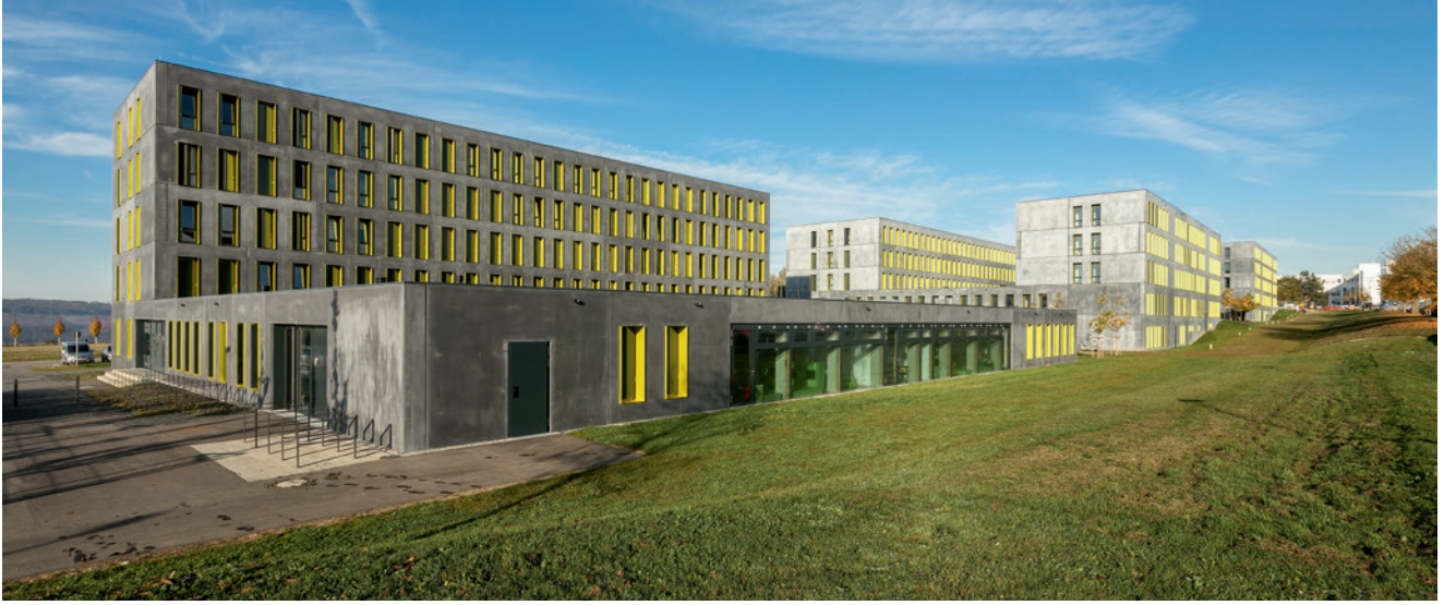
Der dritte Bauabschnitt wurde jüngst fertiggestellt. Neben 98 Wohnplätzen finden hier die Verwaltung und die Kindertagesstätte ihren Platz.
