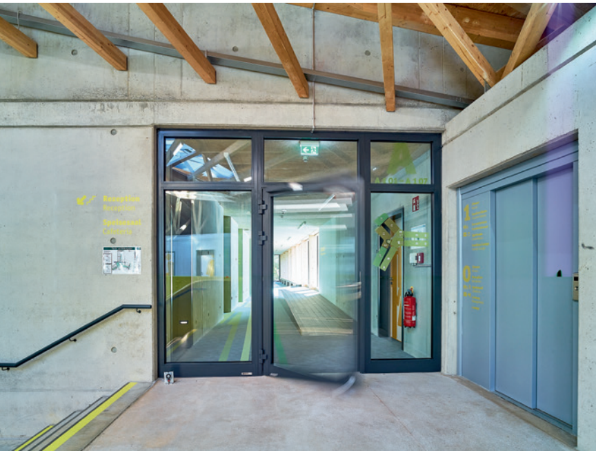
Die Rohrrahmenelemente vereinen Transparenz mit Brandschutzanforderungen.
