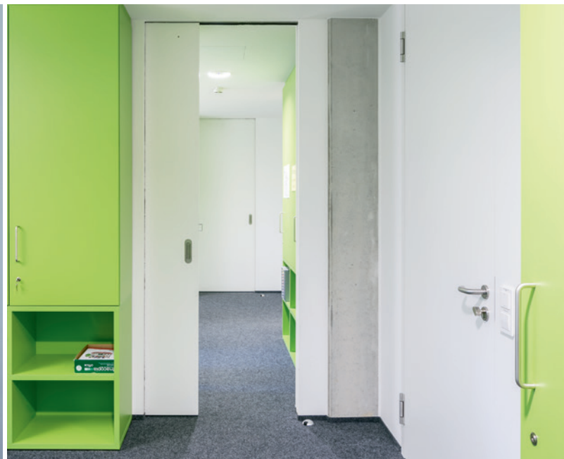
Platzsparende Schiebetüren verbinden die Räume der Verwaltung.
