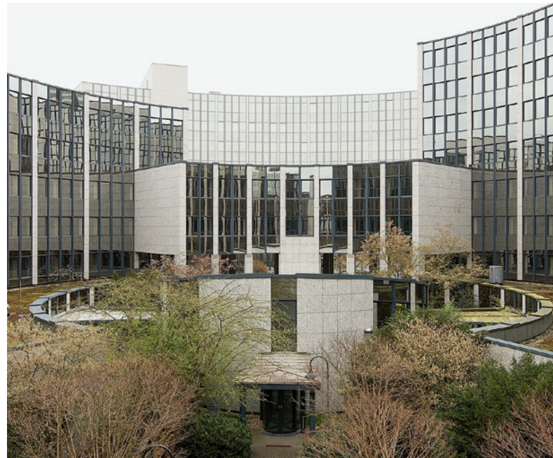
Der Zustand des Gebäudes vor ...
