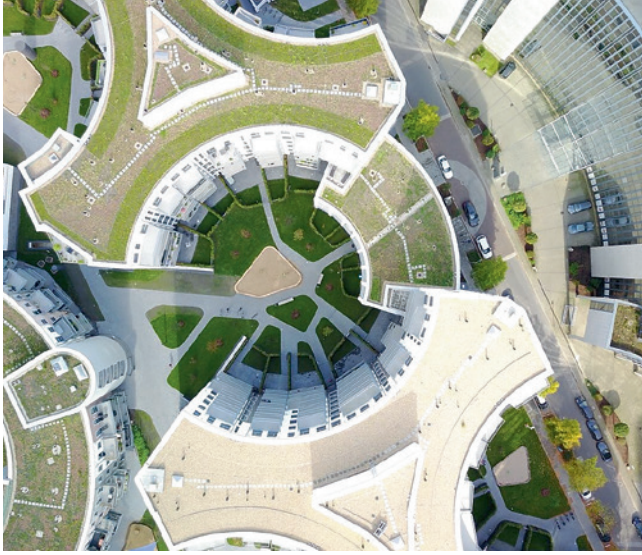
Aus der Luft ist die ungewöhnliche Gebäudeform am besten zu erkennen.
