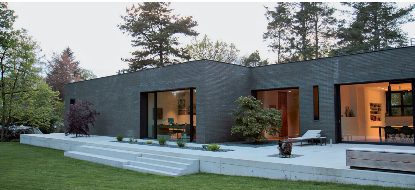
Vom offenen Wohn- und Essbereich sowie vom Arbeitszimmer aus gelangen die Bewohner auf die akkurat gestaltete Terrasse aus Sichtbeton.
