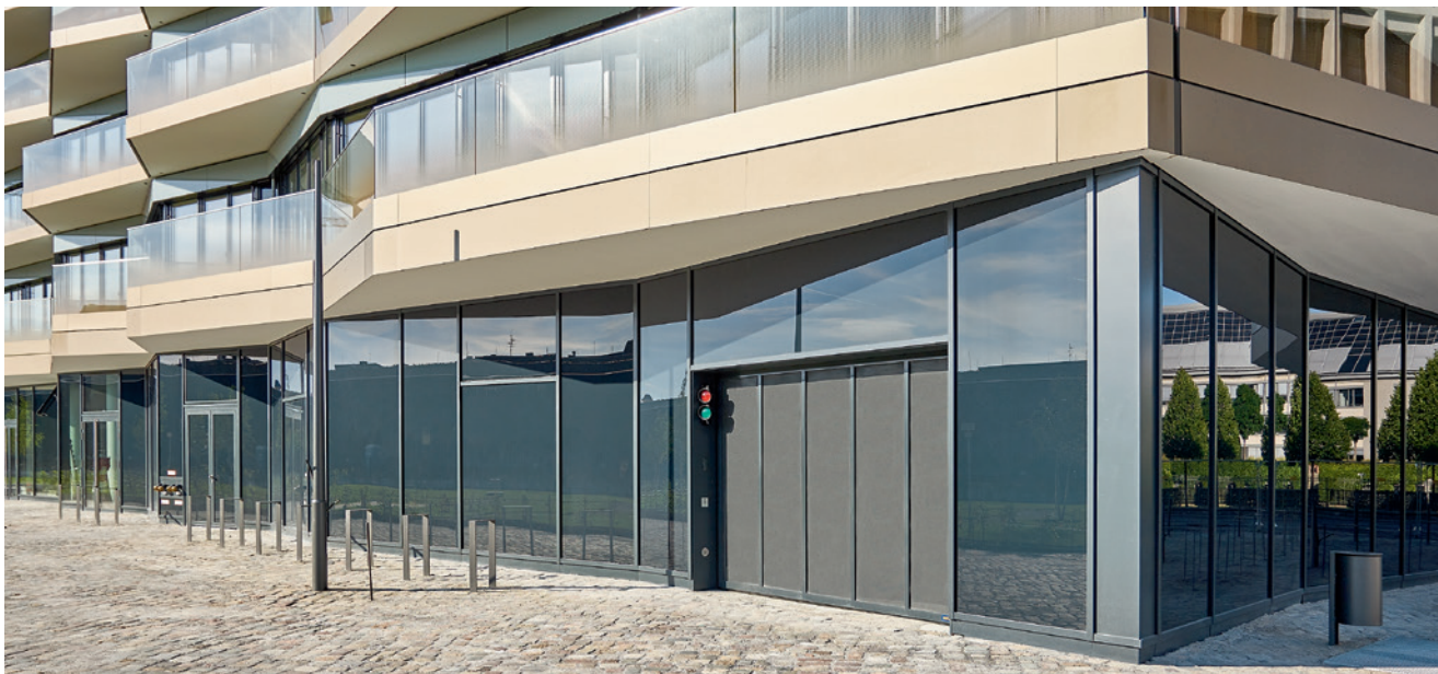
Recht unauffällig integriert sich das Sammelgaragentor in die Fassade. Bei genauerem Hinsehen erkennt man die Abfahrt durch das Streckmetallgitter.
