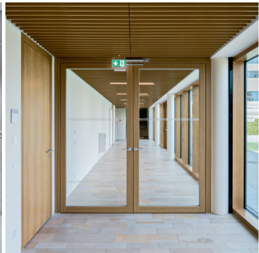
„Seamless“: Auf eine Glashalteleiste kann verzichtet werden.
