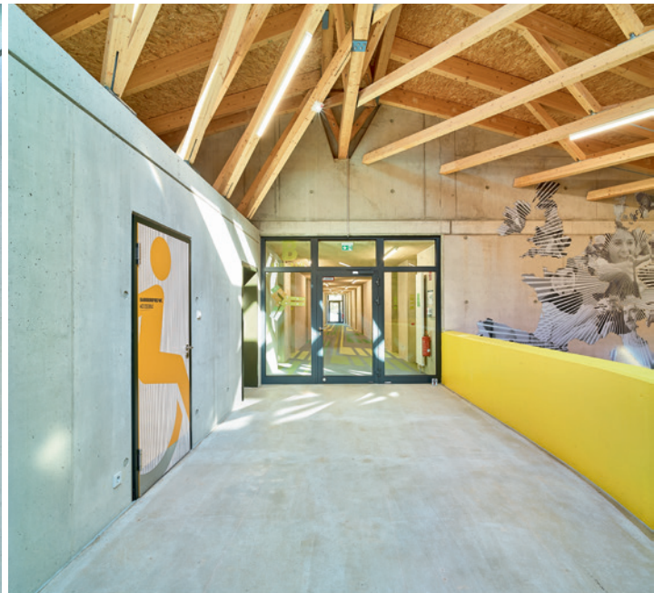
Die Türen bilden den Feuer- und Rauchabschluss der Wohnflügel.
