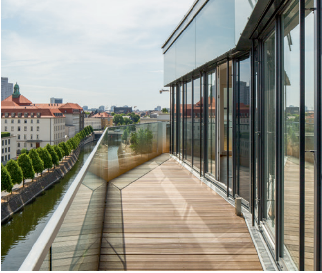
Kristallin: Fassade und Brüstung sind in der Flucht leicht geknickt.
