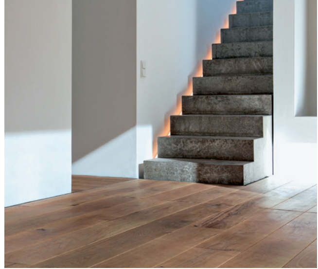
Monolithische Treppe: Der Aufgang aus Sichtbeton ist indirekt beleuchtet.
