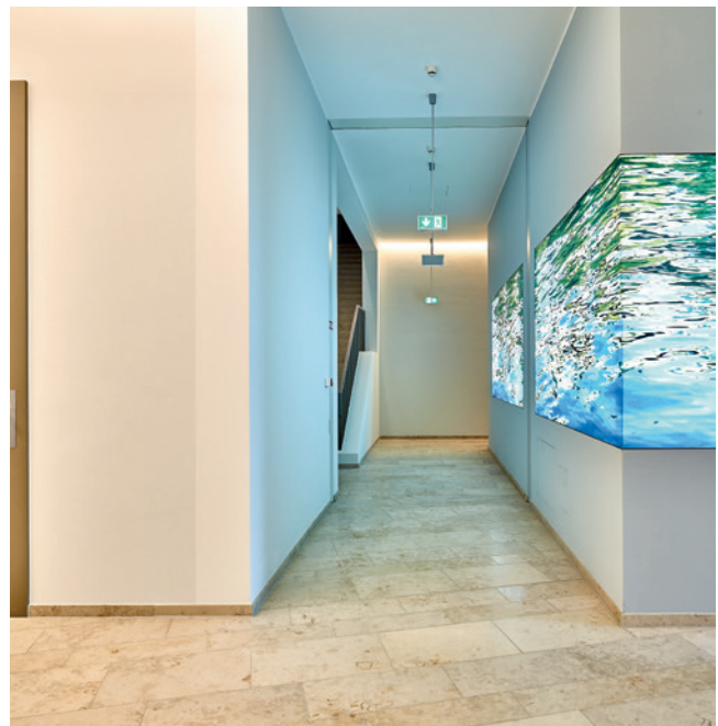
Die Unterteilung des Flures in Brandschutzabschnitte fällt kaum auf.
