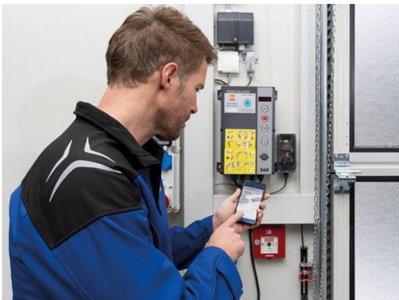
**Bild 6:** Mit der von Hörmann entwickelten App BlueControl können bei der Neuinstallation für einzelne Tore Vorlagen mit allen Parametern erstellt und „per Knopfdruck“ auf identische Anlagen kopiert werden. Dadurch wird eine schnelle und einfache Inbetriebnahme ermöglicht.
