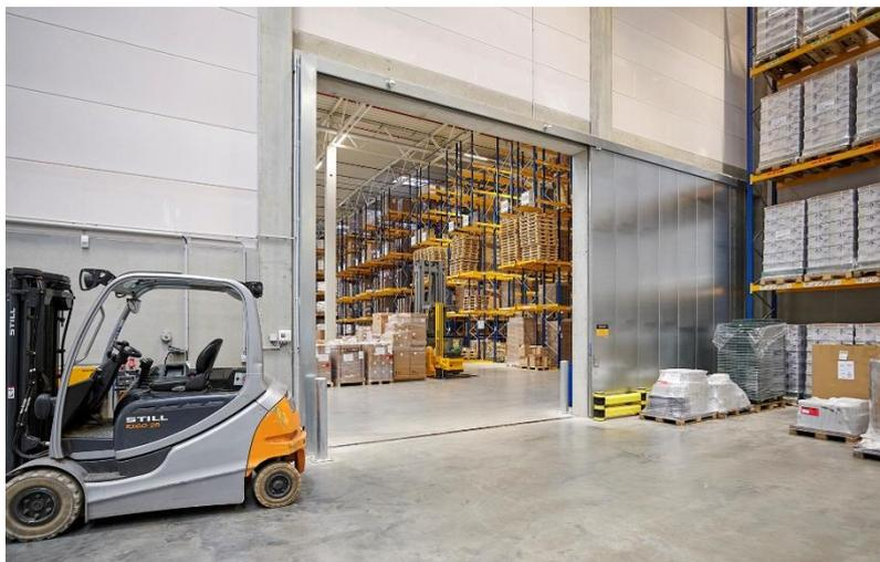
**Bild 6:** Die sechs bei In-Time verbauten Feuerschutz-Schiebetore von Hörmann schließen im Brandfall automatisch und verhindern bis zu 90 Minuten ein Ausbreiten des Feuers auf angrenzende Hallenbereiche.
