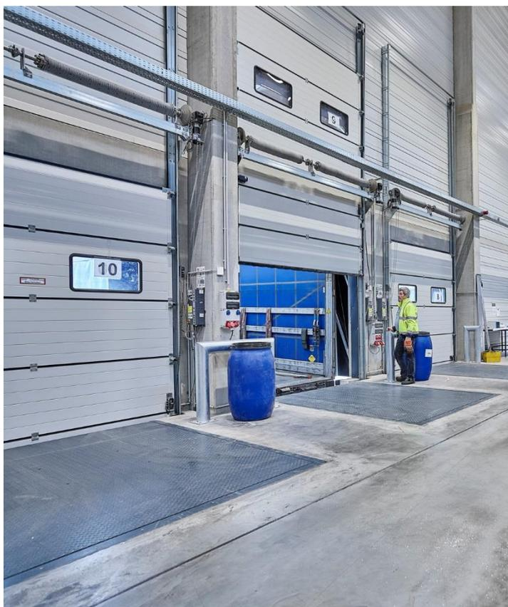
**Bild 2:** An der Schnittstelle zwischen Halle und LKW entschied sich Goldbeck im In-Time Logistikgebäude für hydraulische Vorschub-Ladebrücken vom Typ HTL 2 von Hörmann. Diese ermöglichen je nach Fahrzeugtyp das zentimetergenaue Ausfahren des Ladebrückenvorschubs.
