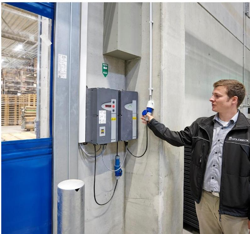
**Bild 8:** Die Hörmann-Schnellauftore vom Typ V5030 SEL dienen als weitere Nachströmöffnungen und wurden deshalb zusätzlich mit einem Puffer-Akku ausgestattet, der auch bei Stromausfall ein schnelles Öffnen und Schließen ermöglicht.
