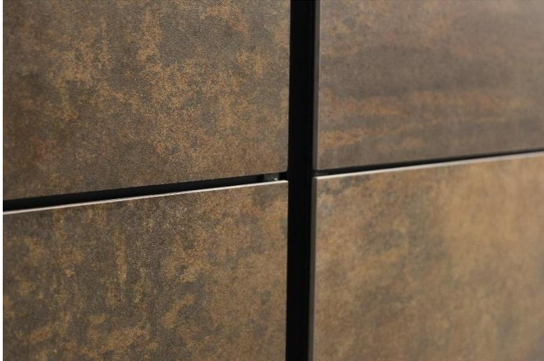
**Bild 2:** Das gewünschte Design (hier im Bild Cortenstahl) wird auf einer 5,5 mm starken mineralischen Grundplatte aus Granit, Schiefer, Quarz und speziellen Glasfaserverstärkungen aufgetragen.
