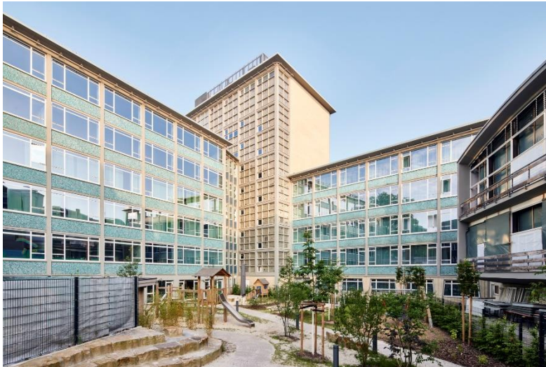
Bild 2: Der Innenhof des ehemaligen Gesundheitshauses wird von der Kita „Villa Luna“ genutzt, die im anderen Gebäudeteil untergebracht ist.
